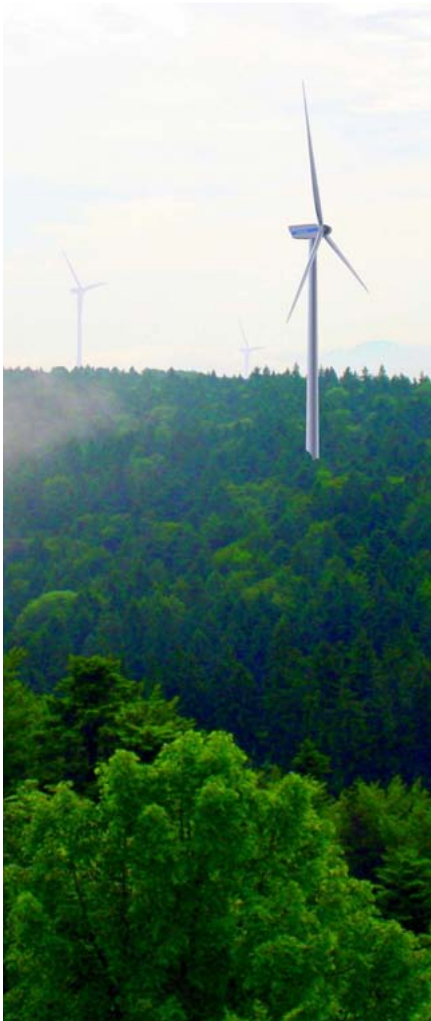
Der geplante Windpark der Basler IWB auf der Challhöchi (Gemeinden Röschenz, Kleinlützel und Burg). FOTOMONTAGE: ZVG
